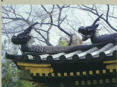
本殿の屋根の四隅に配置されている青銅製彫刻瓦。阿吽の龍頭は他では見られないデザイン。
