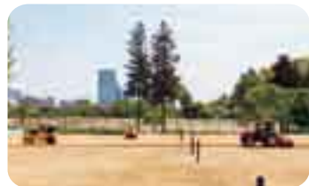
【機械によるしめ固め】
