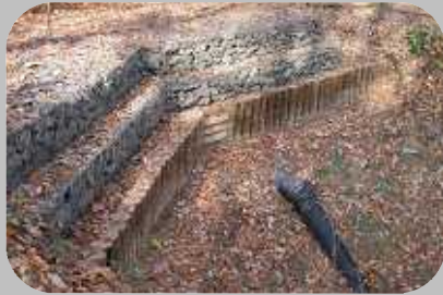
補修された散策路
