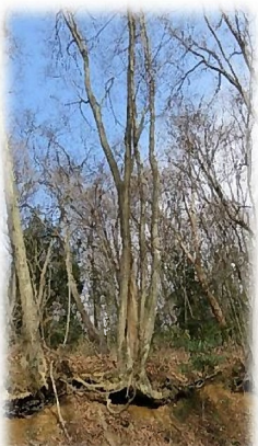
崩れた斜面の根。地中真下よりも横に大きく伸ばす根
