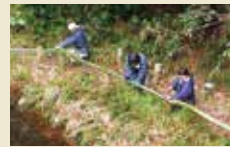
竹手すりを交換
